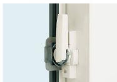
従来の樹脂サッシの 召合クレセント部
