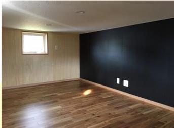
屋根裏部屋には壁と床に防音シートを施しました。壁面の有孔ボードは吸音して反響を抑えるので防音対策に活用できます。今思えば、学校の音楽室の壁に無数の穴があいていませんか？あれが有孔ボードです。アクセントクロスならぬ「アクセント有孔ボード」は黒に塗装しました。黒色が空間を引き締めてカッコイイ印象になります。
